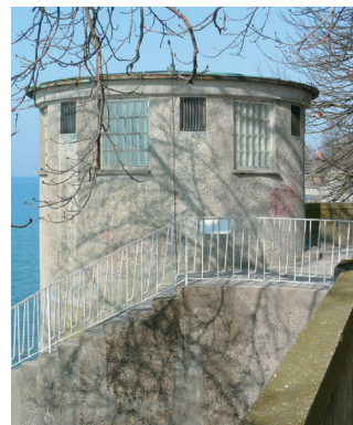
Bild 3: Pumpstation Hintere Insel: In diesem Gebäude vermutet man wahrscheinlich keine Abwasserpumpstation, man denkt eher an einen kleinen Aussichtsturm.
