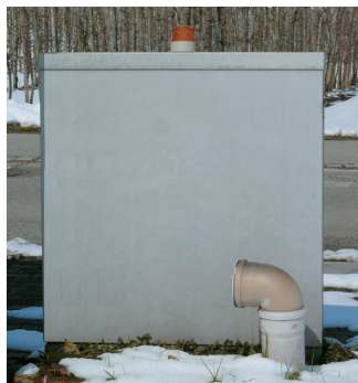
Bild 1: Diese kleinen Pumpstationen leiten das Abwasser mit bis zu 10 l pro Sekunde zum Hauptpumpwerk.
