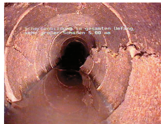
Bild 2: Schaden durch Scherbenbildung
