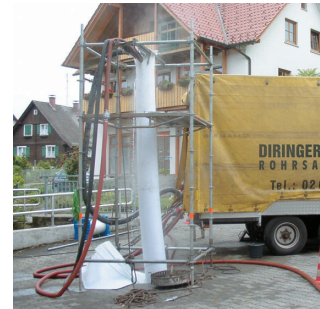
Einbau im Bräuweg.
