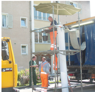
Sanierung in der Wiedemannstraße
