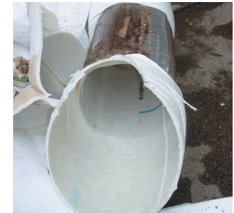
Fertiges „Rohr im Rohr“.
