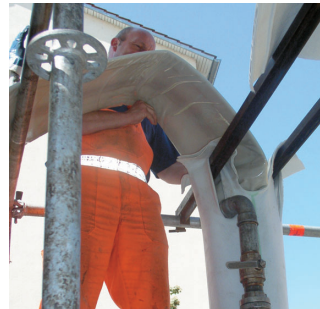
Einführen des Schlauches in das Kanalrohr.
