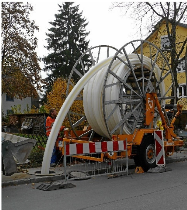
Einbau des Rohres in der Köchlinstraße
