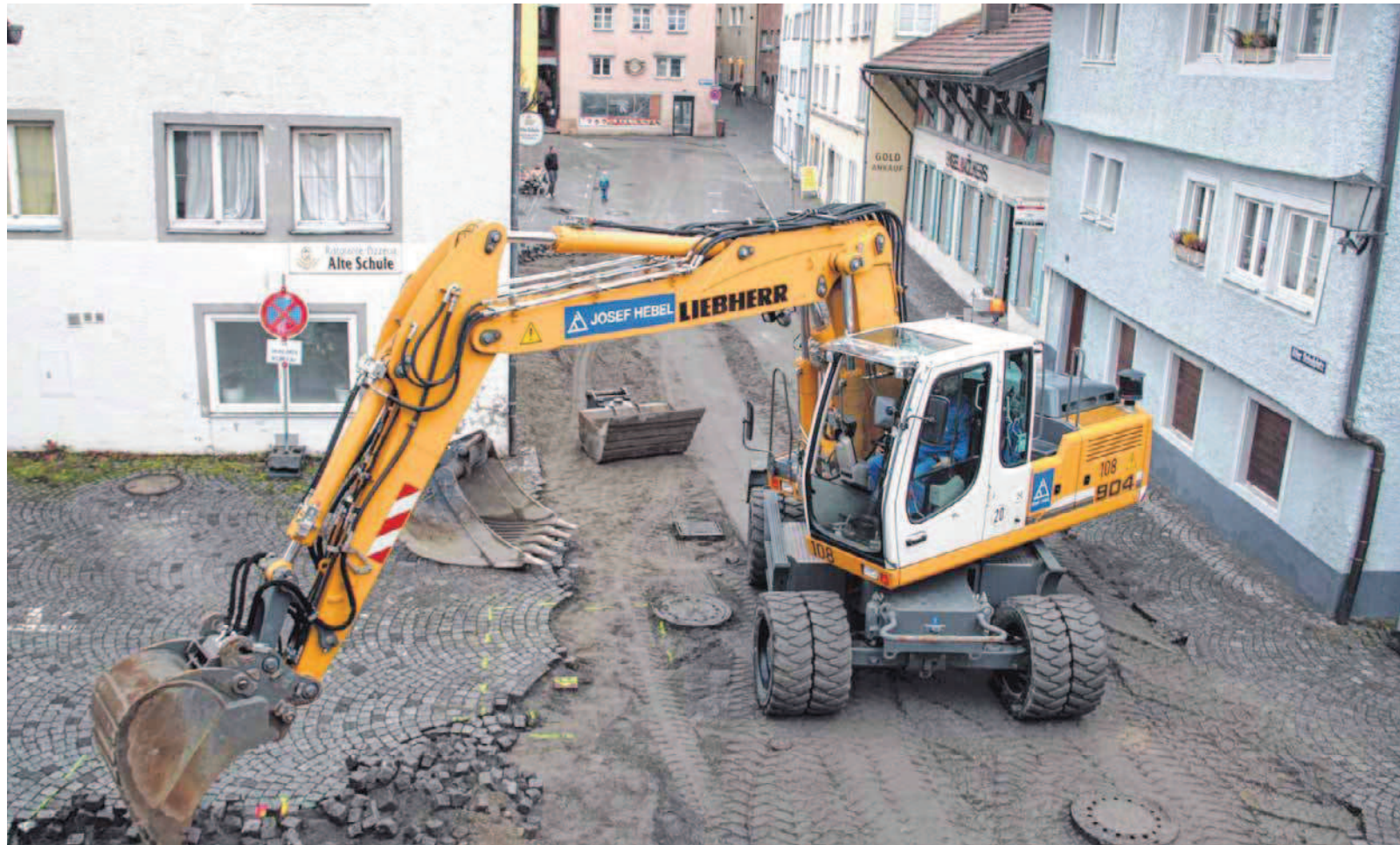
Die Bauarbeiten am Alten Schulplatz haben begonnen.
